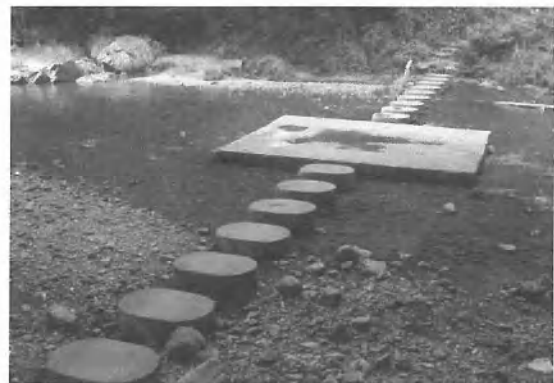
写真-4 ドレミファ橋
