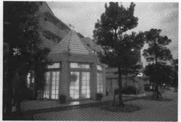
プラスワン住宅(多摩ニュータウン)
