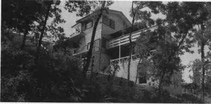
斜面住宅(南足柄市)
