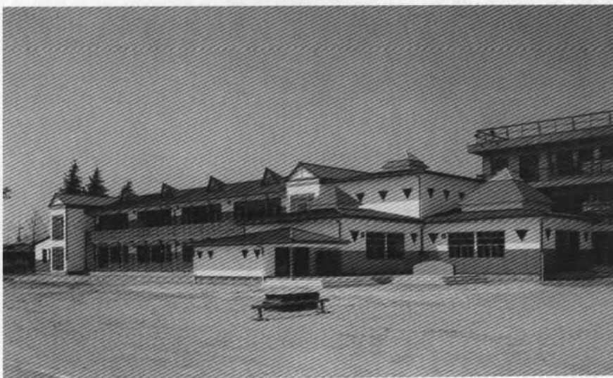
木造の小学校(茨城県瓜連町立瓜連小学校)
